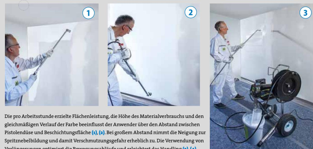
Die pro Arbeitsstunde erzielte Flächenleistung, die Höhe des Materialverbrauchs und den gleichmäßigen Verlauf der Farbe beeinflusst der Anwender über den Abstand zwischen Pistolendüse und Beschichtungsfläche (1), (2). Bei großem Abstand nimmt die Neigung zur Spritznebelbildung und damit Verschmutzungsgefahr erheblich zu. Die Verwendung von Verlängerungen optimiert die Bewegungsabläufe und erleichtert das Handling (3), (4).
